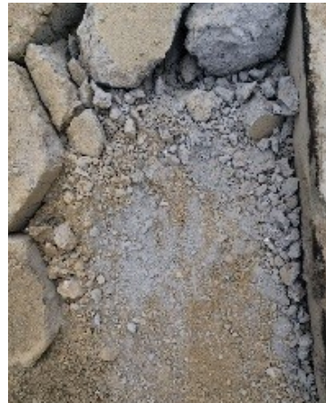
図 9. 衝撃によるブロックの崩壊
